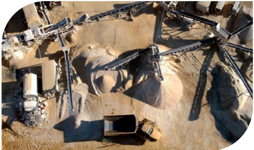
Source : Exploitation – Stock Photos (Bim).
